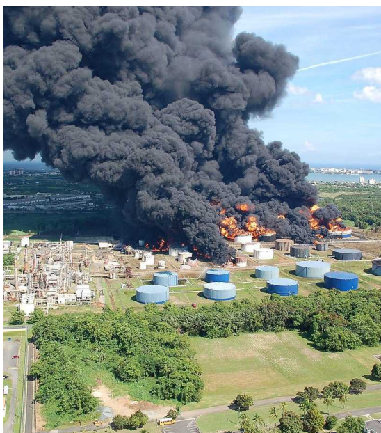
プエルトリコの石油タンク・ターミナルの爆発火災 (2009 年)
