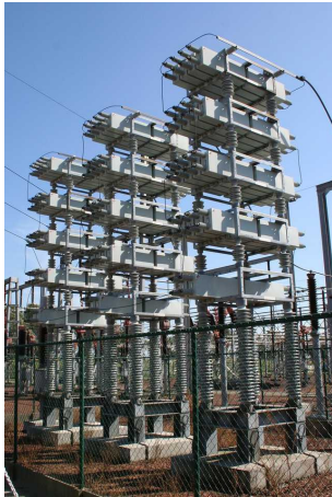
図 1: 高圧電力系のコンデンサ・バンクの例
